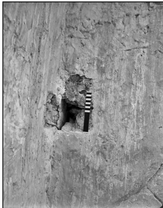
Рис. 31. Примыкание восточной аркады к южной стене мечети. Зондаж. Вид с востока. Фото автора. 1985 г.
