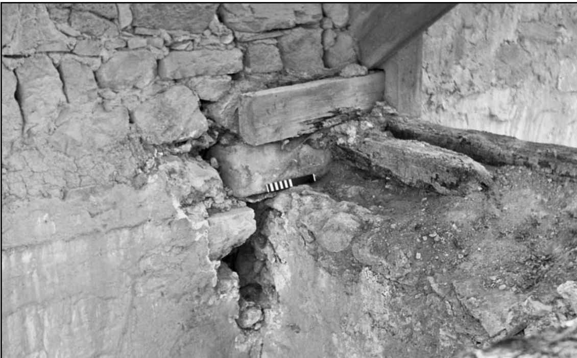
Рис. 38. Примыкание восточной аркады к северной стене мечети на уровне перекрытия. Вид с юго-запада. Фото автора. 1985 г.
