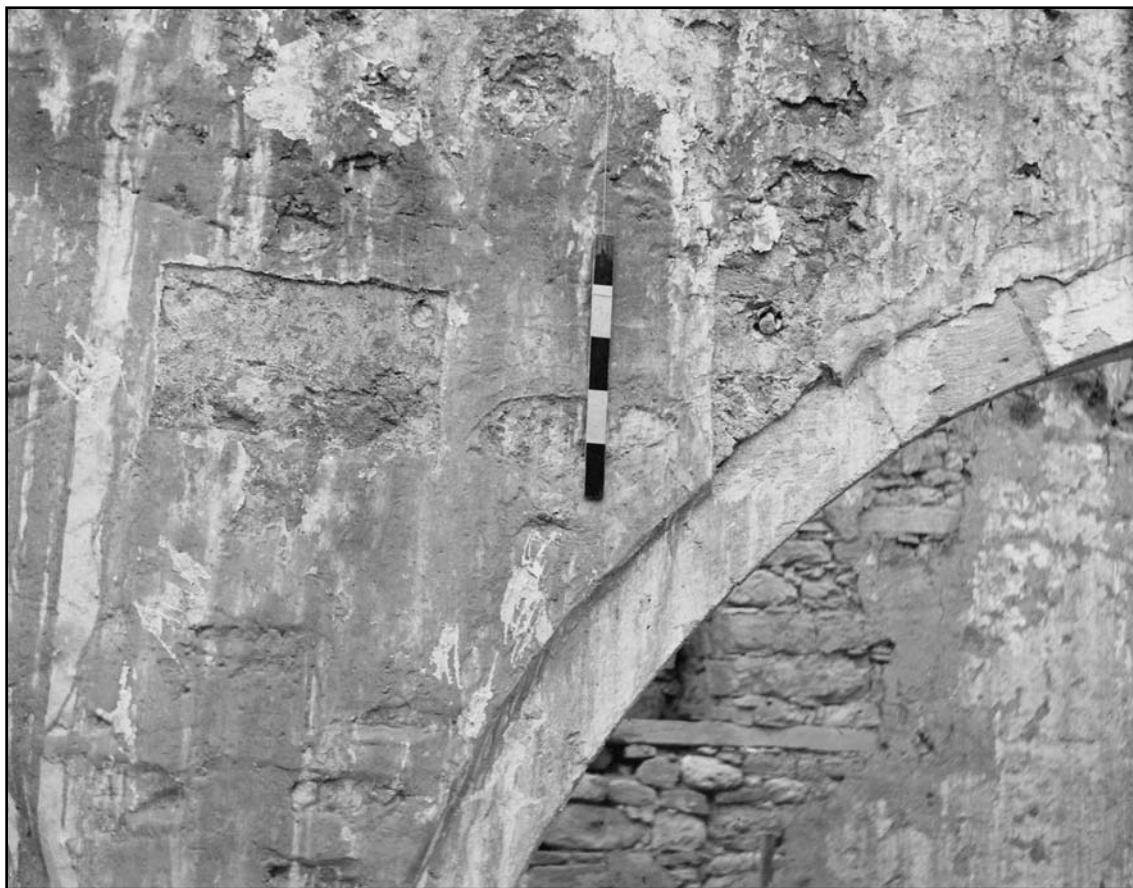
Рис. 36. Голосники в кладке западной аркады мечети. Зондаж. Вид с запада. Фото автора. 1985 г.
