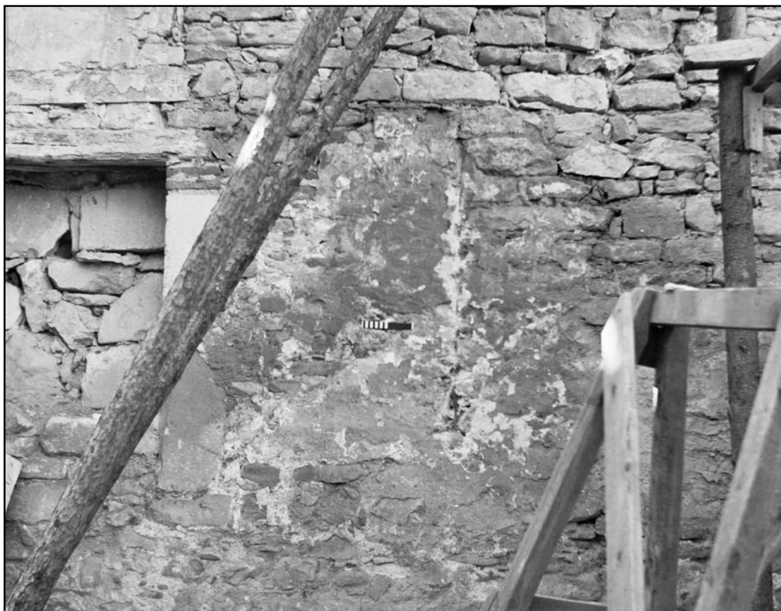
Рис. 22. Западные окна южной стены мечети. Вид с севера. Фото автора. 1985 г.
