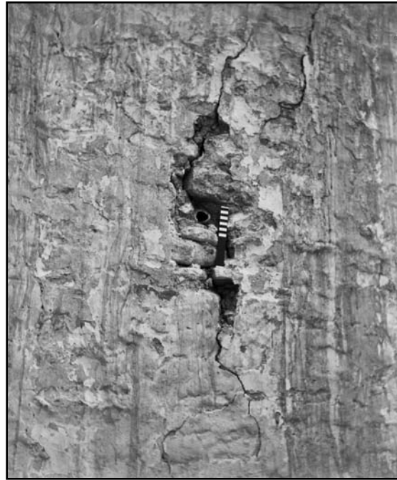
Рис. 30. Голосник в кладке южной стены мечети. Вид с севера. Фото автора. 1985 г.
