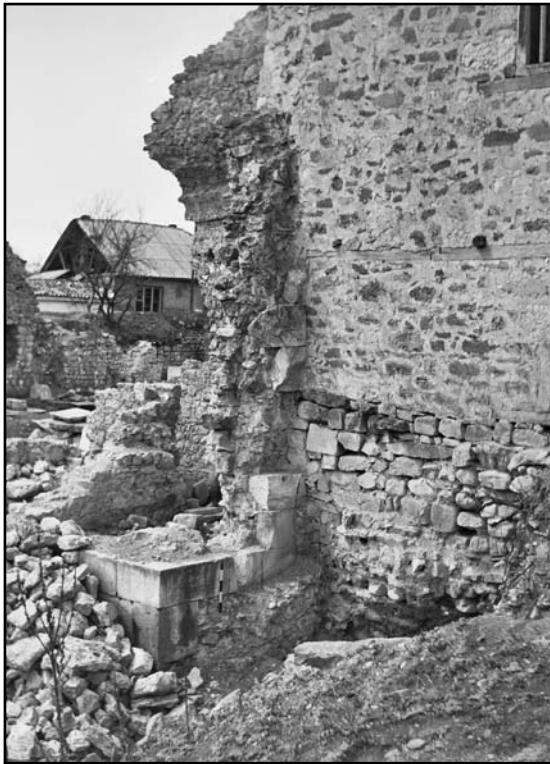
Рис. 15. Примыкание мечети к медресе. Вид с северо-востока. Фото автора. 1985 г.
