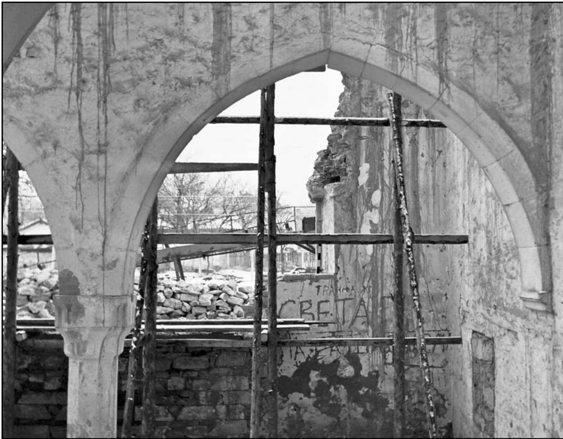
Рис. 40. Северное окно западного фасада мечети второго строительного периода. Вид с востока. Фото автора. 1985 г.
