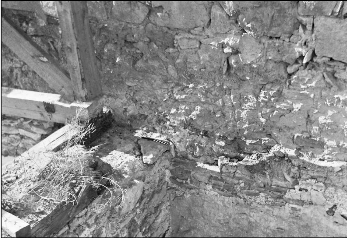
Рис. 37. Примыкание восточной аркады к южной стене мечети на уровне перекрытия. Вид с северо-запада. Фото автора. 1985 г.
