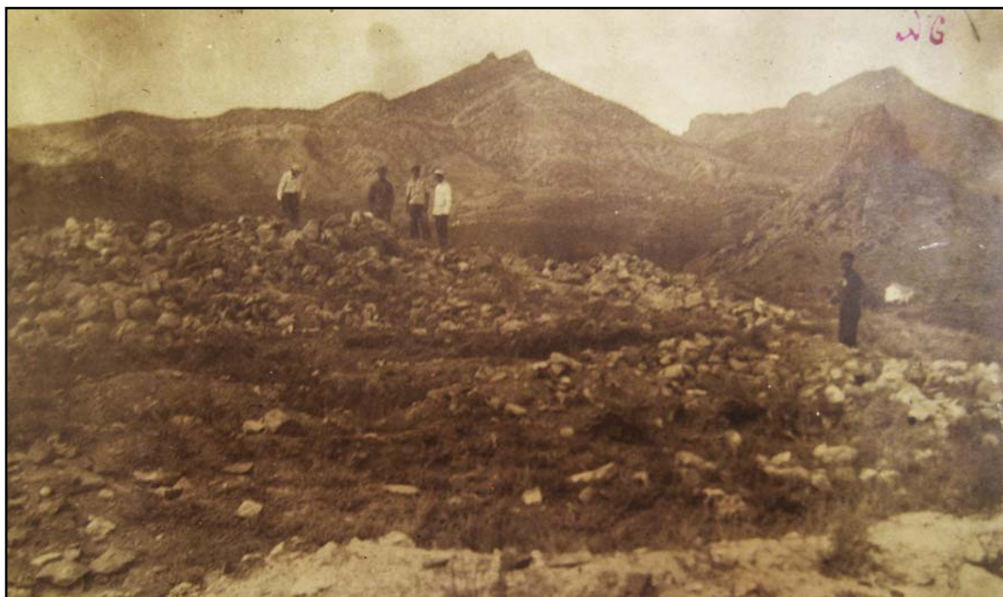
Рис. 5. Общий вид разрушений укрепления на горе Кордон-Оба (фото Н.С. Барсамова, 1927 г. Архив ФМД, КП 25236, НА 318).
