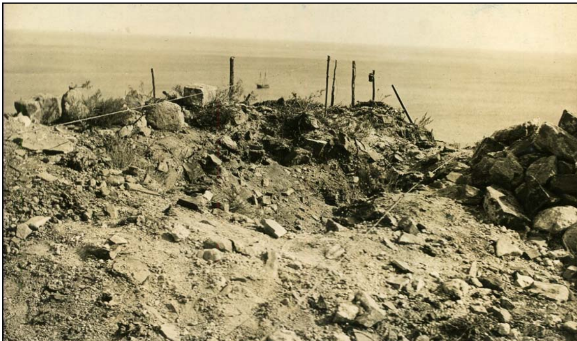
Рис. 28. Замок Калиера. Башня перед началом исследований 1928 г. Вид с севера (фото Н.С. Барсамова, 1928 г. Архив ФМД. КП 25236, НА 318).
