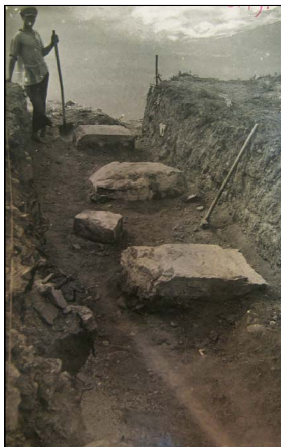
Рис. 19. Разведочная траншея в башне замка Калиера. Раскопки 1927 г. Вид с северо-востока (фото Н.С. Барсамова, 1927 г. Архив ФМД, КП 25236, НА 318).
