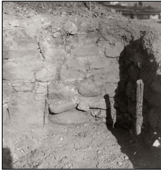
Рис. 31. Замок Калиера. Юго-восточный угол башни, исследования 1928 г. Вид с северо-запада (фото Н.С. Барсамова, 1928 г. Архив ФМД, КП 25236, НА 318).
