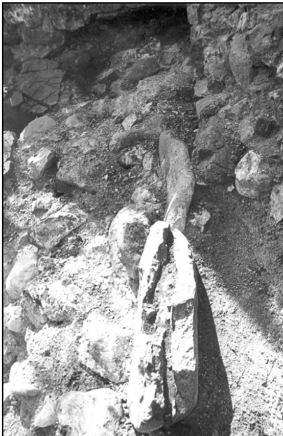
Рис. 22. Тылный участок оборонительной стены цитадели. Фрагмент лицевого слоя кладки. Вид с юго-востока, сверху (по Сидоренко 1982: рис. 16).
