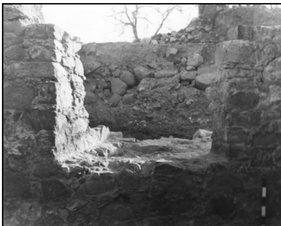
Рис. 54. Амбразура в боковой стене нижнего этажа башни Орта-Куле. Вид с северо-запада (по Мыц, Адаксина, Кирилко 1993: рис. 20).
