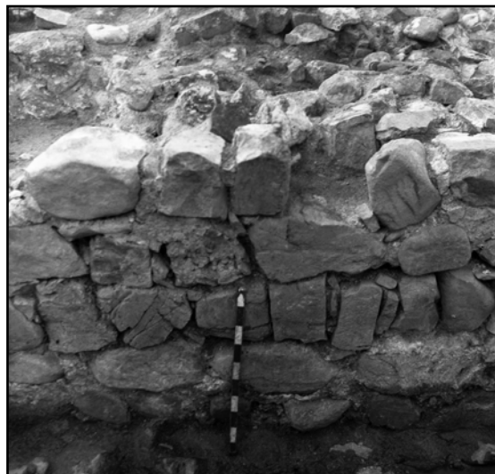
Рис. 16. Кладка переднего фасада ранневизантийской оборонительной стены напольной стороны цитадели. Вид с северо-востока. 1987 г. Фото В.Л. Мыца.
