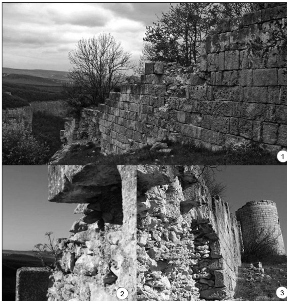
Рис. 15. 1. Оборонная стена Сюйренской крепости. 2. «Позднеримские пакеты» (забутовка мелким камнем на известковом растворе между квадрами тесаных блоков). 3. Фрагмент стены со снятыми тесаными квадратными блоками. Фотографии автора, 2009 г.
