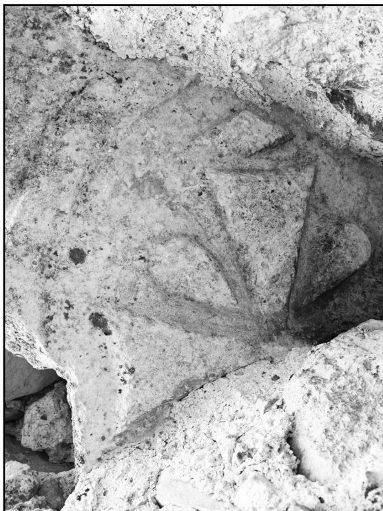
Рис. 8. Лицевая перемычка оконного проема, вторично использованная для перекрытия ружейной бойницы. Общий вид снизу.
